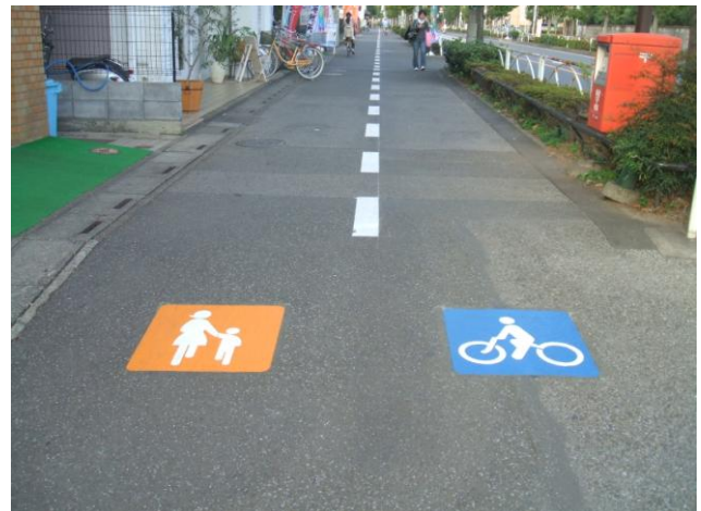
(写真2) 通行帯を示すマーク
