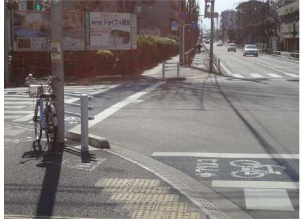
車道とは柵、歩道とは植栽で分離されている。車道の歩道寄りを専用道に変更したため、路面は歩道側に側溝による段差と傾きがある。一方通行。交差点直前で専用道が切断され、横断待機する歩行者と交錯する。横断歩道の自転車通行帯を利用するため、歩行者自転車信号に従う。
