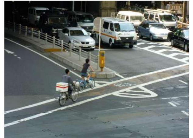
交差点付近にポールを立てることで自動車からの巻き込みを防ぎ、交差点内の自転車レーンに誘導している。歩行者は歩道橋を利用するため、交差点横断用自転車レーンが設けられている。
