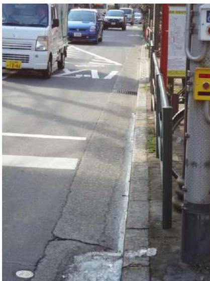
側溝蓋が傾斜しているため、低速通行ではバランスを崩す原因の1つになる。
