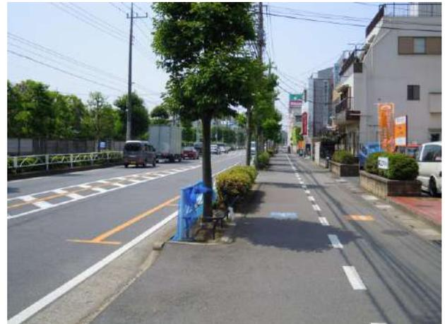
歩道上の自転車通行帯で、車道とは植栽と柵で分離されている。路面は平坦である。相互通行で交差点は歩行者自転車信号に従う。自転車通行帯と歩行者通行帯を示すマークが2.8m間隔で路面に添付されている。
