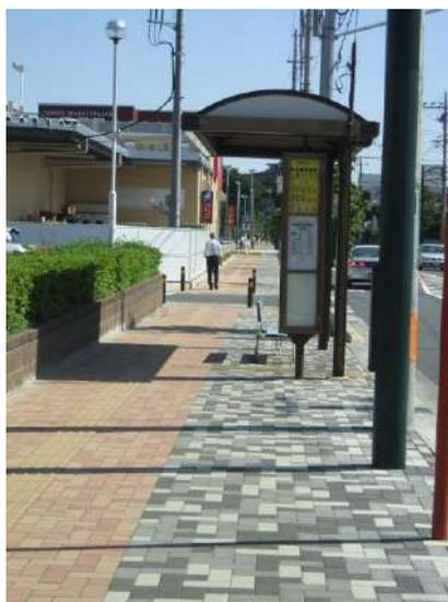
バス乗車用溜まり場を確保するために専用道が歩道に食い込む形になっている。自転車と歩行者との接触の危険性がある。
