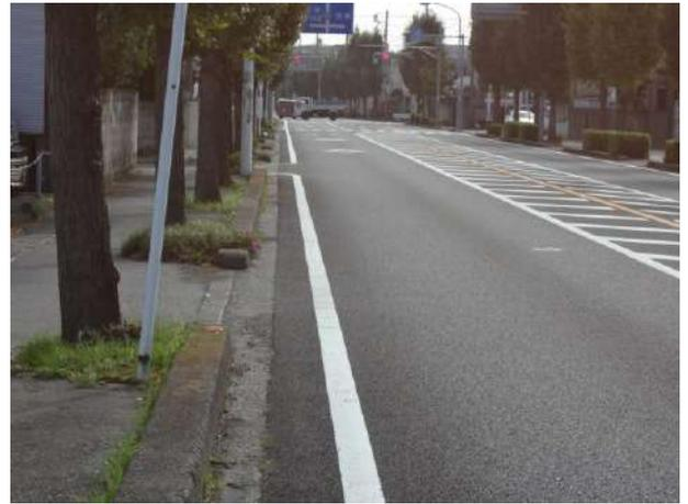
路側帯における傾斜と側溝部分との段差があるため、低速ではバランスを崩す原因の1つとなる。
