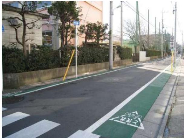
路側帯の中央に電柱、歩道寄りに側溝蓋による段差と傾斜があるため、路側帯内通行が困難である。
