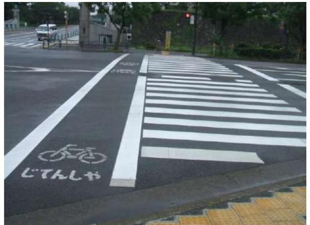
自転車通行帯があるため、車道通行の自転車は直進するときでも交差点で一度左折を行った後直進する。この結果左折直後通行帯に入る際、左折してそのまま直進する車両と接触する可能性がある。
