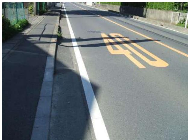
車両乗り入れ用ステップの設置が路側帯内通行を阻害している。
