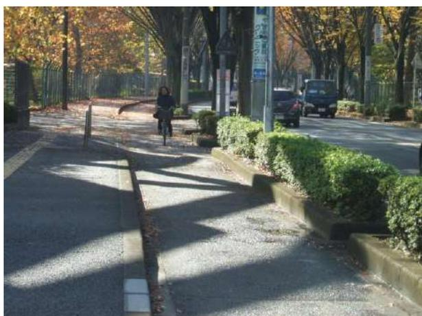
車道とは植栽で、歩道とは段差で分離されている。路面は平坦である。専用道は片側車線のみで、反対車線は自転車通行可の歩道だけである。相互通行。交差点は直線通行可能で車道の信号に従う。
