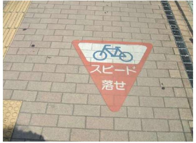
自転車のイラスト入りで「スピード落せ」のマークが歩道上の車道寄りではなく、車道と反対側の路面に添付されている。
