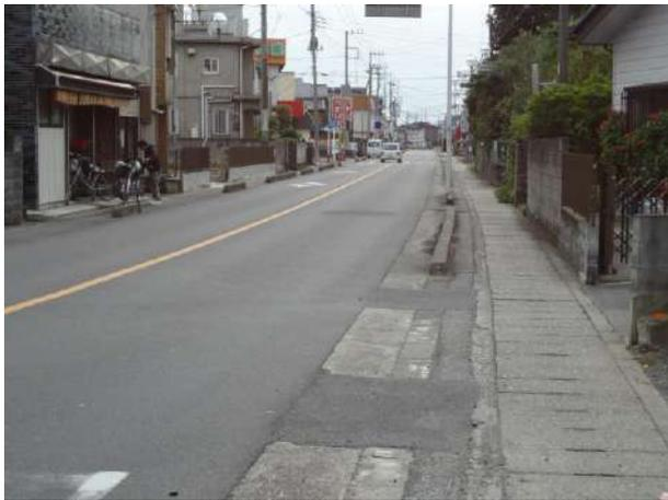
ブロック脇の路面の凹凸が低速ではバランスを崩す原因の1つとなる。
